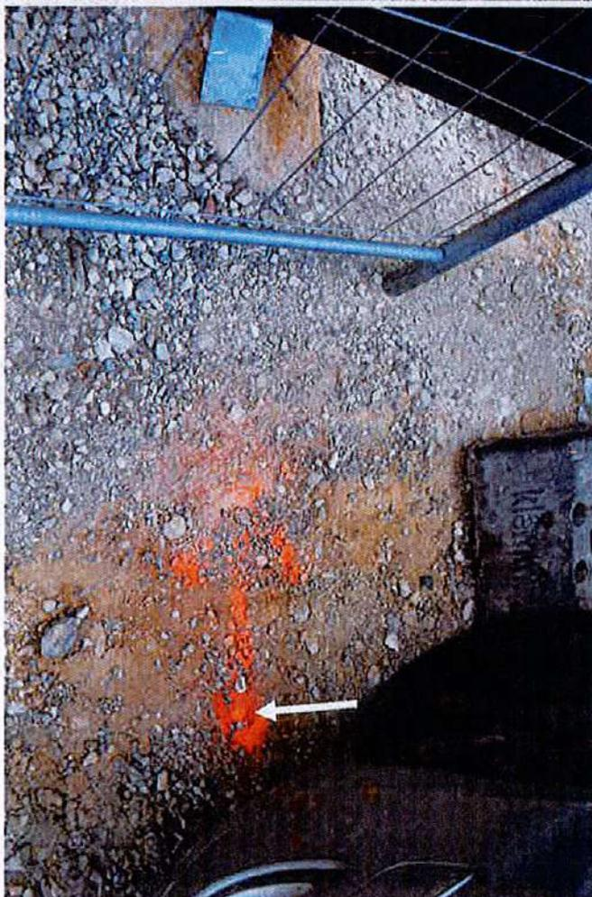
Le rappel de ce clou de géomètre est écrit à la peinture orangée sur l'enrobé de la chaussée quelques mètres plus loin, toujours au droit du portail.
